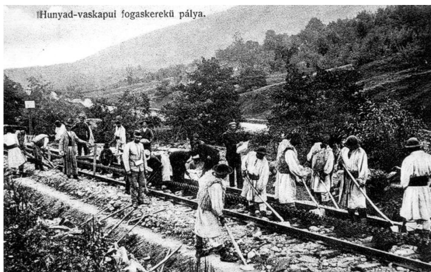
Porțile de fier ale Transilvaniei – Băuțari – Se lucrează la linia ferată montană cu cremalieră
