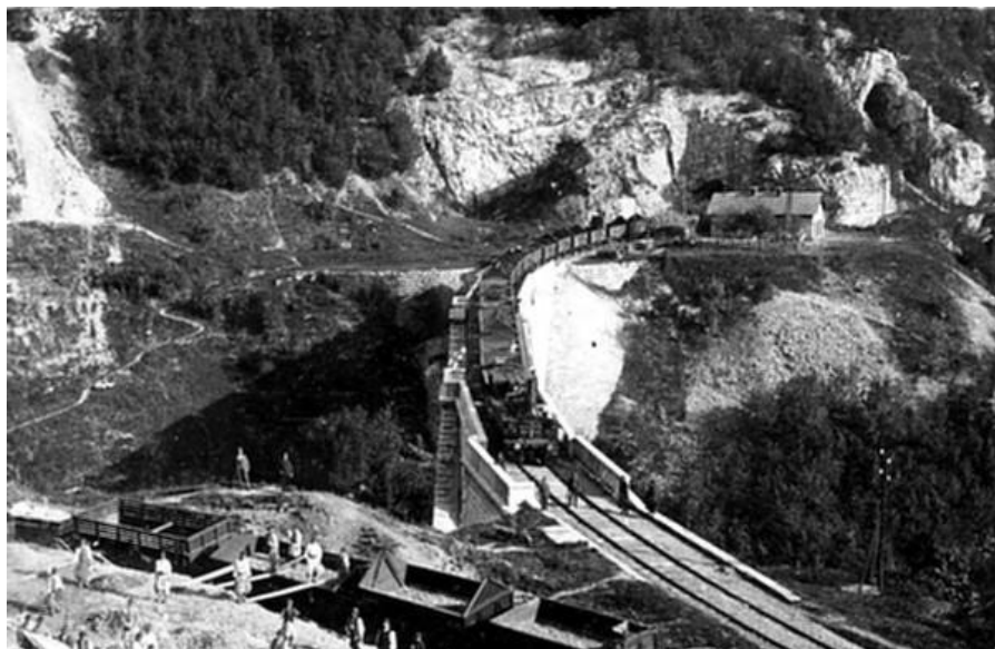
Construcție Viaduct Anina – 1929
