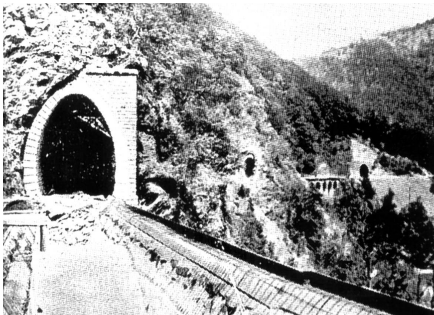
1948 – Calea ferată Bumbști – Livezeni Tunele în construcție
