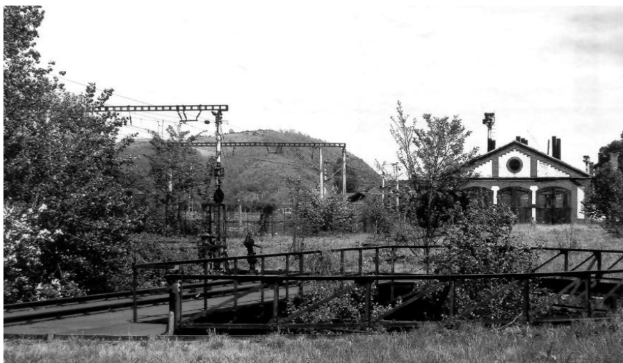
Subcetate – depoul de locomotive cu placa rotativă pentru schimbarea căii de rulare a locomotivelor
