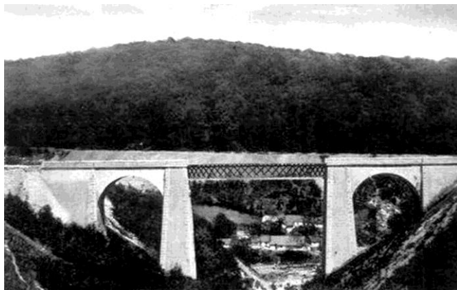
Podul viaduct de cale ferată Anina
