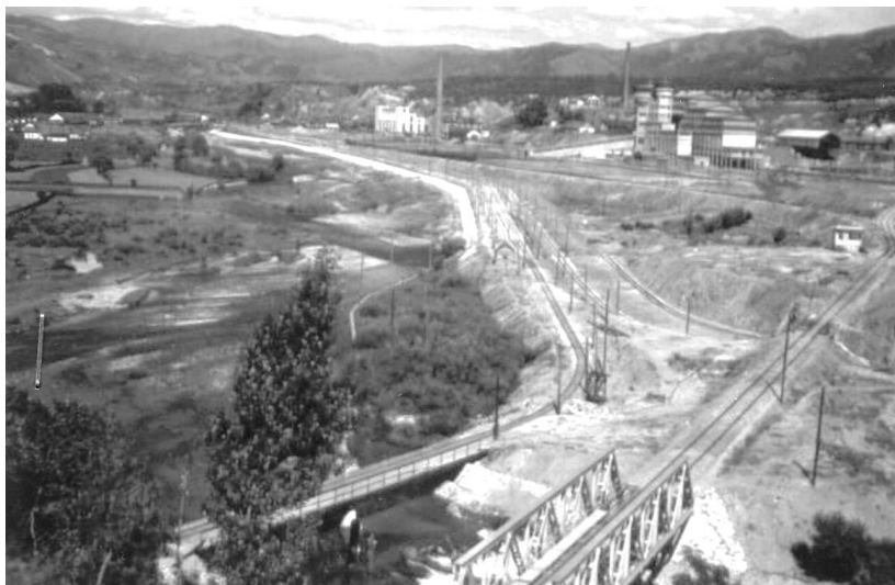
Petrila 1932 – Două linii ferate gemene – linia ferată Petroșani triaj – Preparația Petrila (ecartament 1432 mm) – în stânga linia ferată îngustă Lonea separator - nord
