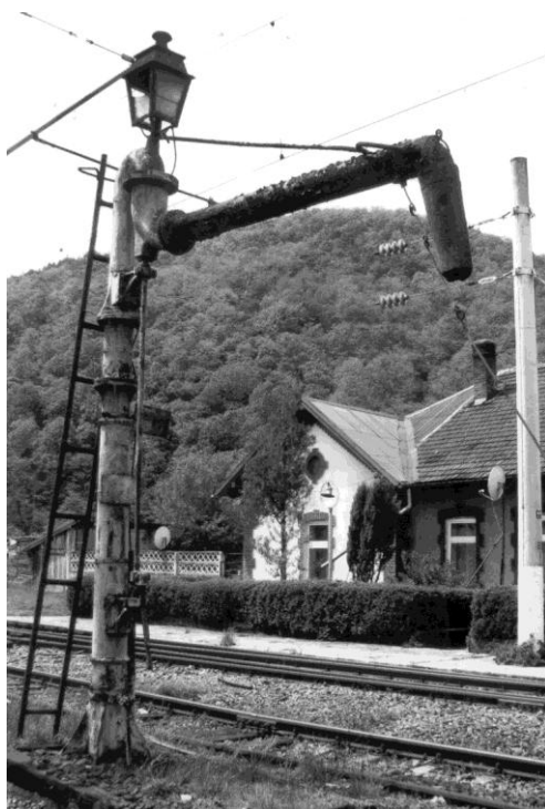
Gara Subcetate – Fântâna pentru alimentarea locomotivelor cu aburi
